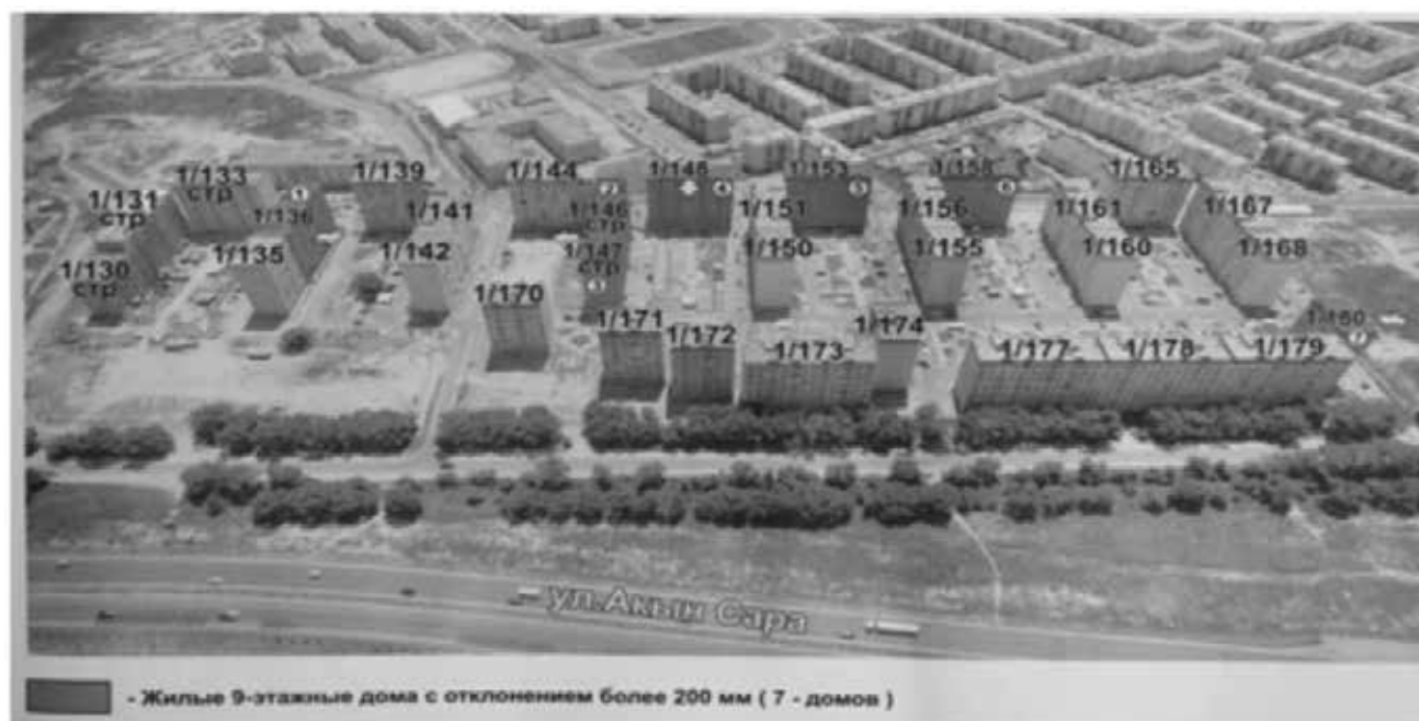
Рис. 5. Смещение отдельных жилых зданий.
