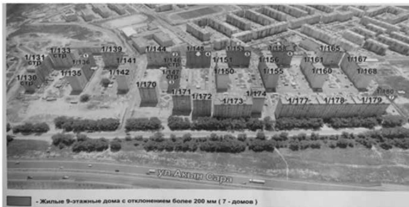
Рис. 2. Смещение отдельных жилых зданий.
