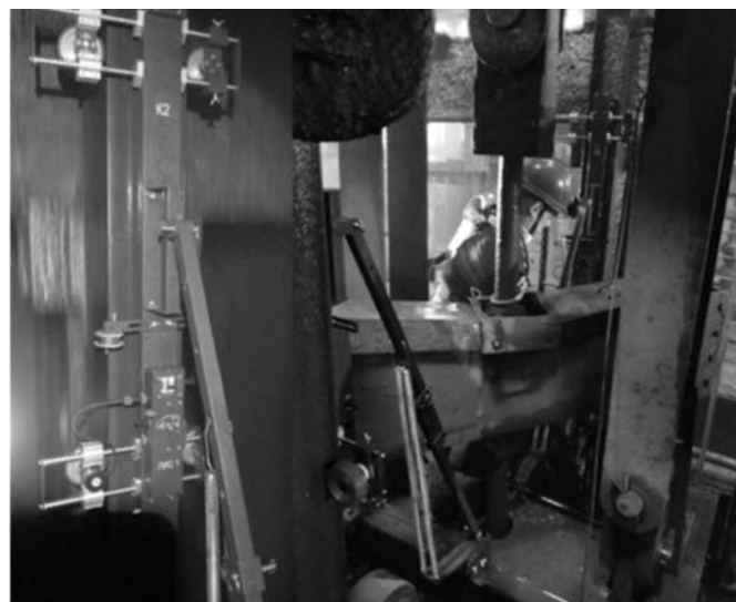
Рис. 4. Крепление станции «ЛИС 1» к проводнику / Fig. 4. Attachment of «LIS 1» station to the conductor
