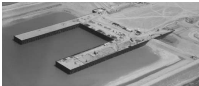
Рис. 2. Причальные сооружения морского канала / Fig. 2. Berthing facilities of the sea channel
