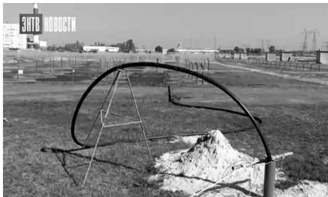
Рис. 1. Артезианская скважина, питающая брызгательные бассейны станции
