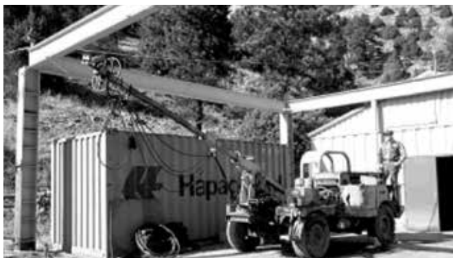
Рис. 13. Оборочная машина с гидромониторным рабочим органом Fig. 13. Waterjet rock scaling machine
