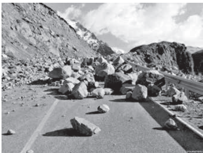
Рис. 7. Обрушение горных пород / Fig. 7. Rock collapse
