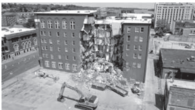
Рис. 6. Обрушение жилых помещений / Fig. 6. Collapse of residential premises
