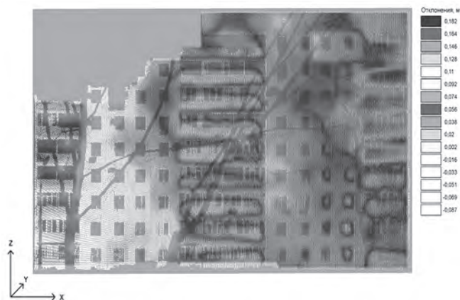
Рис. 2. Модель главного фасада девятиэтажного дома с нанесенным градиентом отклонения панелей от вертикали / Fig. 2. Model of the main facade of a nine-story building with a gradient of panel deviation from the vertical applied
