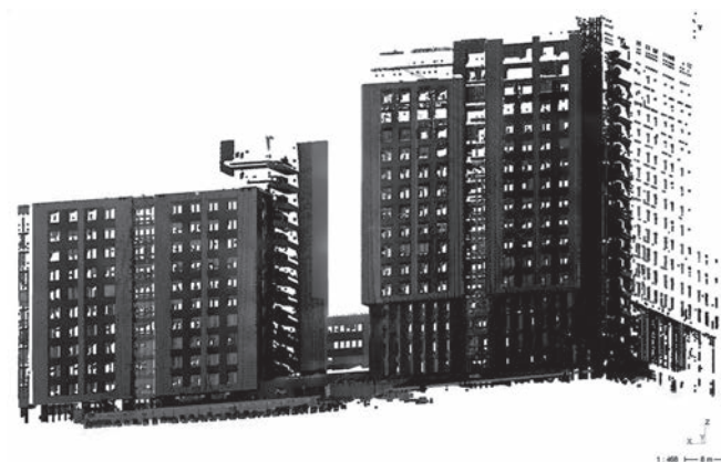
Рис. 4. Облако точек по результатам лазерного сканирования на станции 1. Вид 1 /
