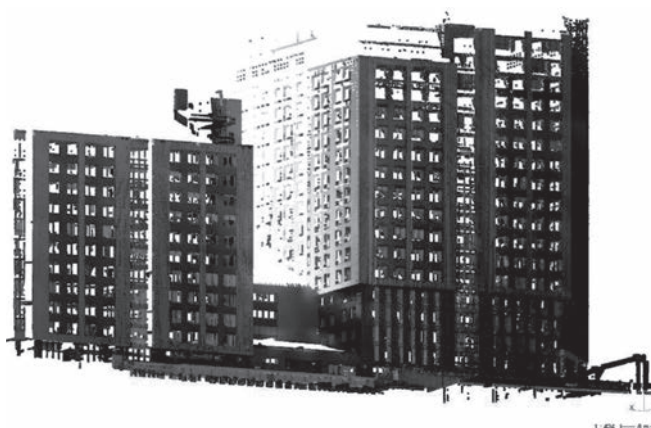
Рис. 5. Облако точек по результатам лазерного сканирования на станции 2. Вид 2 /
