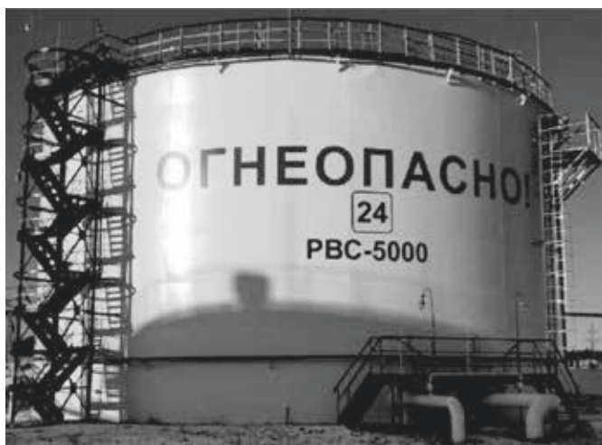
Рис. Резервуары для хранения нефтепродуктов объемом 5 тыс. куб. метров Fig. Storage tanks for petroleum products with a volume of 5000 cub. meters
