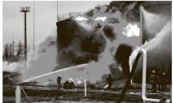
Рис. 3. Авария в резервуарном парке по хранению нефти с открытым пламенем / Fig. 3. Accident in an open flame oil storage tank farm
