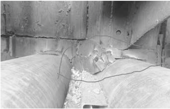
Рис. 9. Приваренные пластины между шпунтовым ограждением котлована и трубами защитного экрана /
